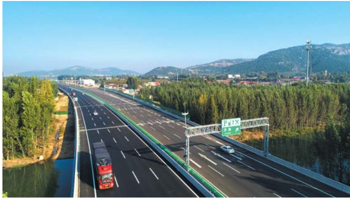
10月12日,京台高速济南至泰安段改扩建项目建成通车。
