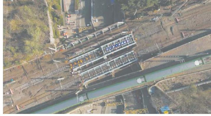
公司经理刘元宝介绍,桥上高压、通讯等电缆纵横交错,桥梁更换位置处于另外两条铁路线中间,其中上行距既有线仅3米,繁忙时
