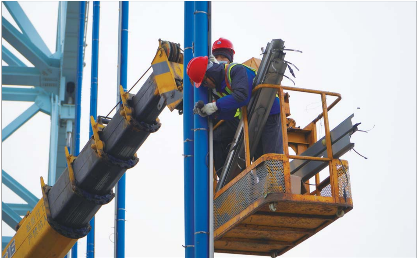
南二环特大桥点光源维护更换。
