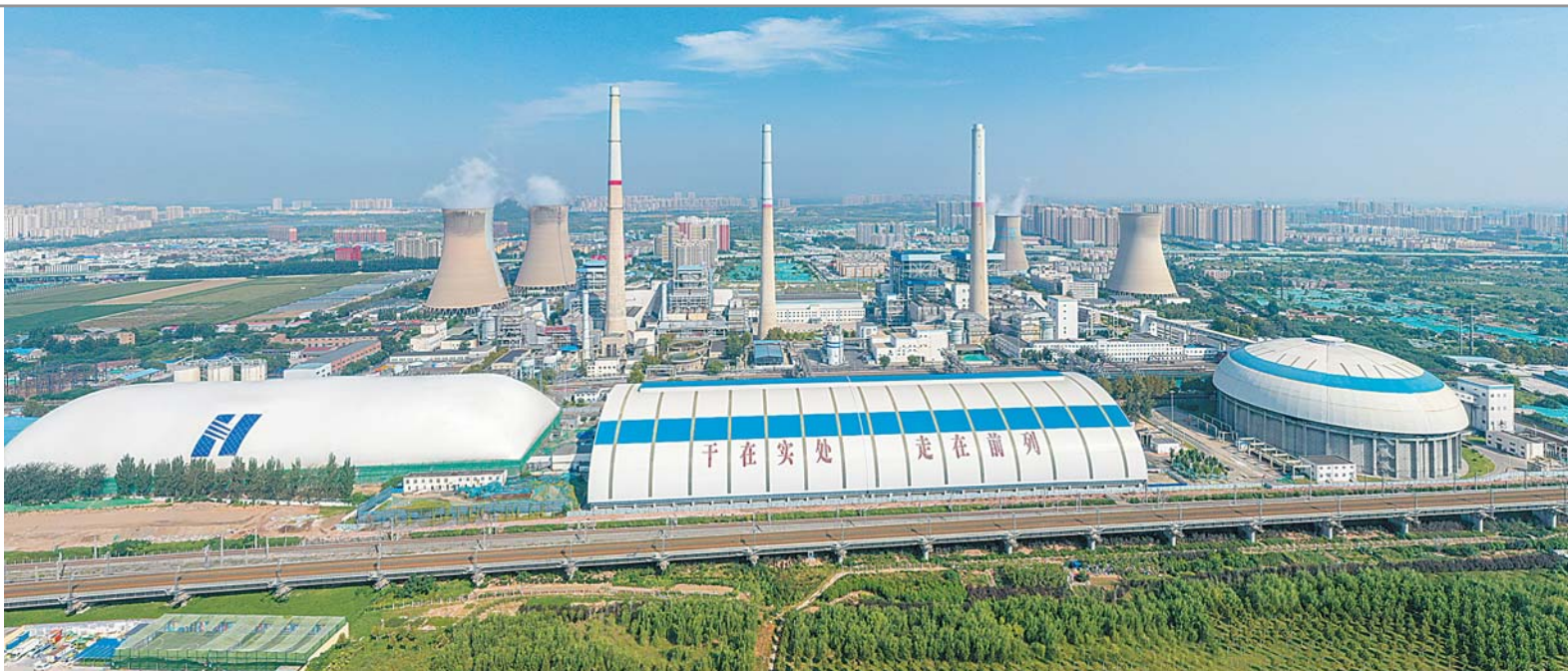
黄台电厂全景
