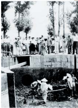
1946年小清河五柳闸挑挖淤泥时的情形。
