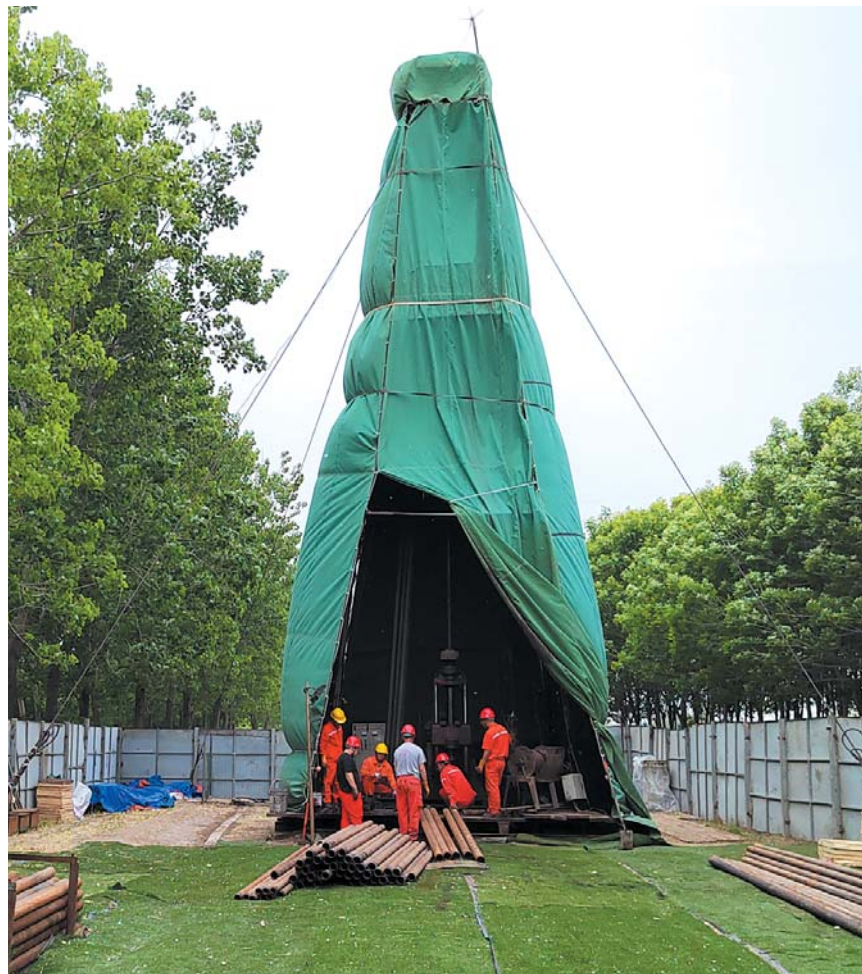
在莱州市山东黄金的一处勘探点，钻探机正在进行地下地质取样。 记者 钟建军 摄
