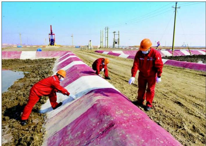
近日,胜利油田河口采油管理十区员工对大北滩海油田刚刚修建施工完成的新型“水泥毯防潮围堰”施工质量进行检查。
