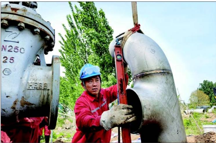
近日,胜利油田滨南采油管理三区经过38个小时鏖战,高效完成南海井工厂至27号计量点的集输干线6处阀组改造工作,消除因阀组导致的干线压力升高问题。
