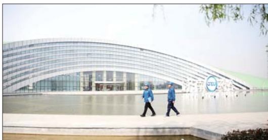
国网济南供电公司员工走进济南药谷产业园区，对园区内企业开展上门走访服务。 本报通讯员 张治林 摄
