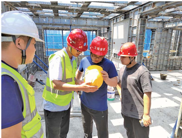
检查组工作人员现场对防护用品进行检查。
