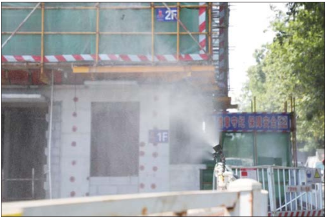
建筑工地每隔3米设置一个水雾喷头。
