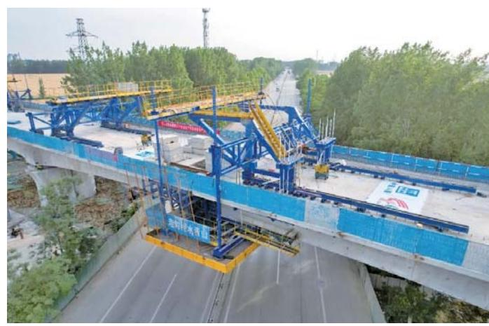
风险分析,搭设高空作业平台,四周设置安全防护围挡,及时疏解施工区域下方交通,确保既有线路的行车安全。
