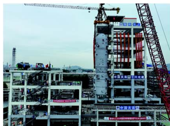
鲁南化工3000吨级OMB多喷嘴对置式粉煤加压气化炉
