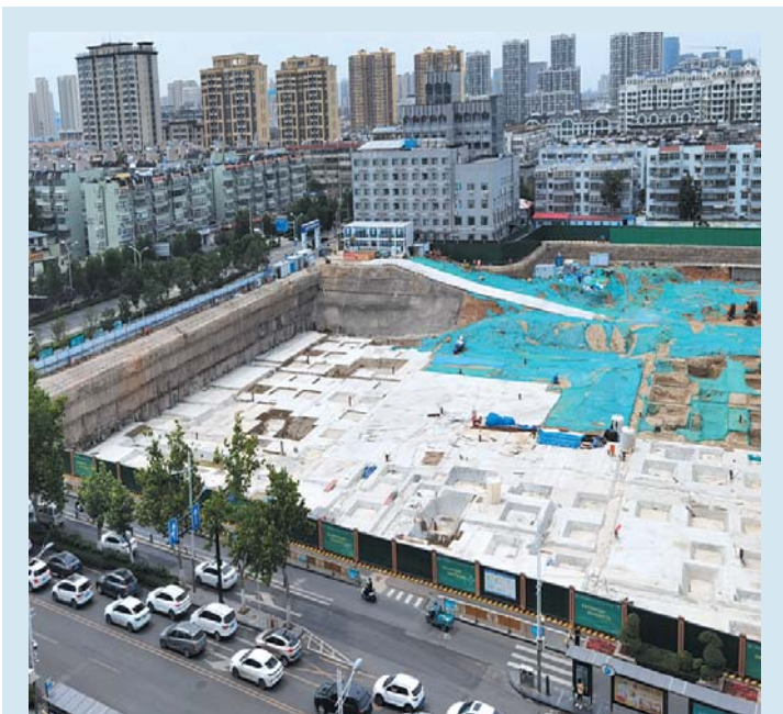
近日，记者探访发现，山东德云文化广场项目只挖了地基，现场不见施工人员和车辆。 记者 李梦瑶 摄
