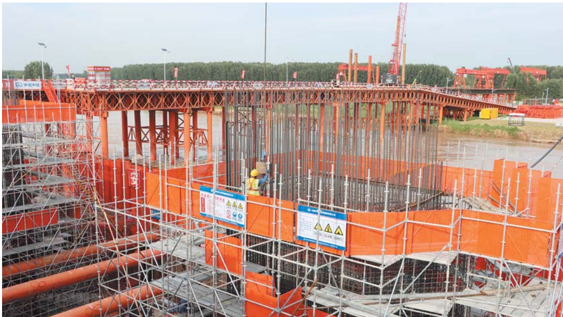
济滨高铁项目建设现场。
