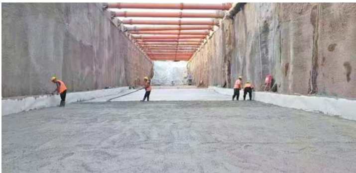
有轨电车地下通道建设现场。
