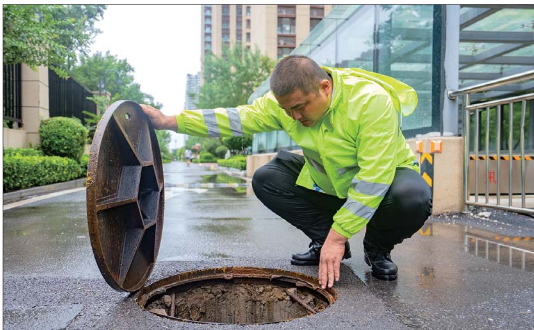
小区物业工作人员检查下水管道。
