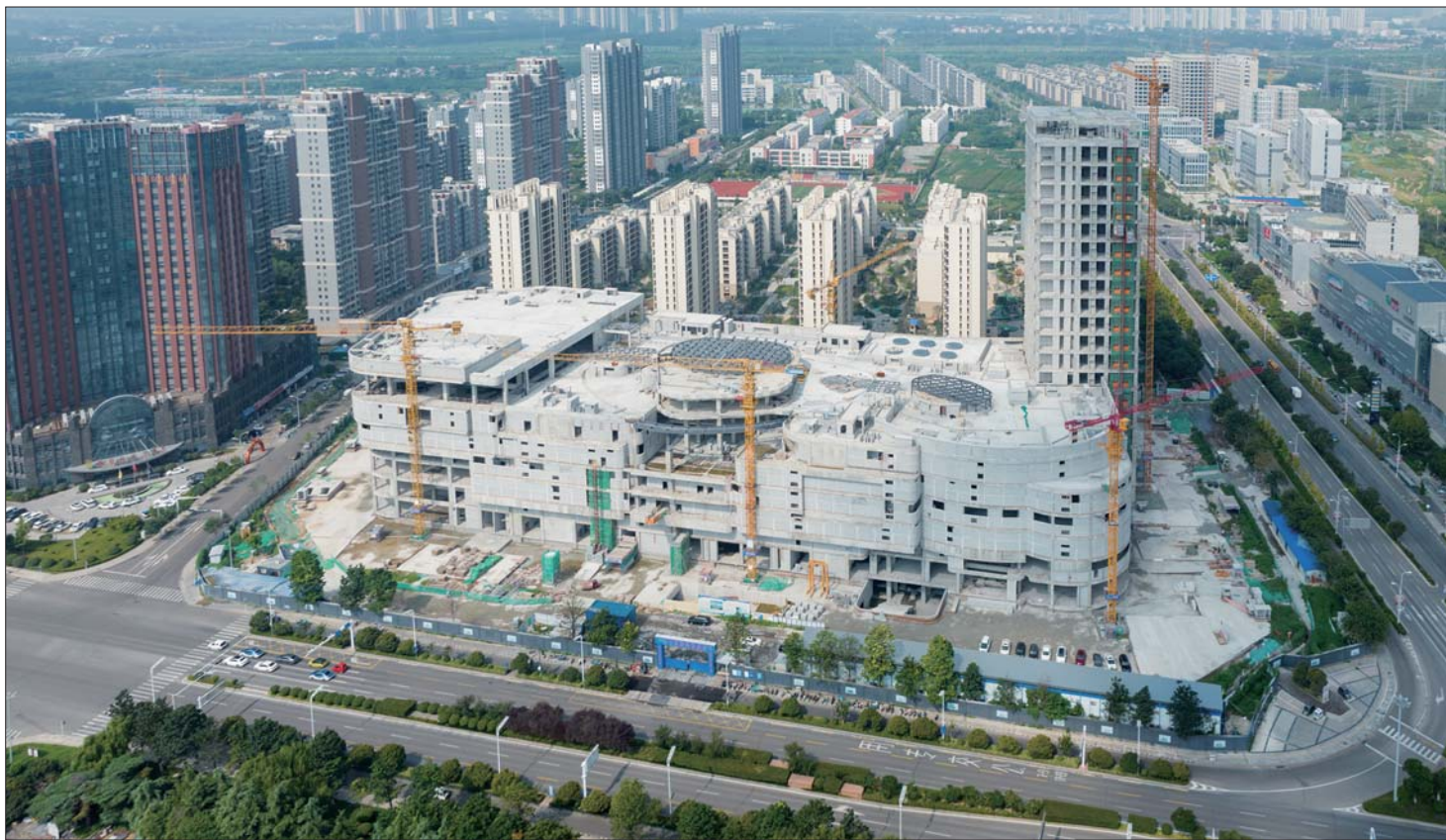
正在建设中的龙贵购物广场。
