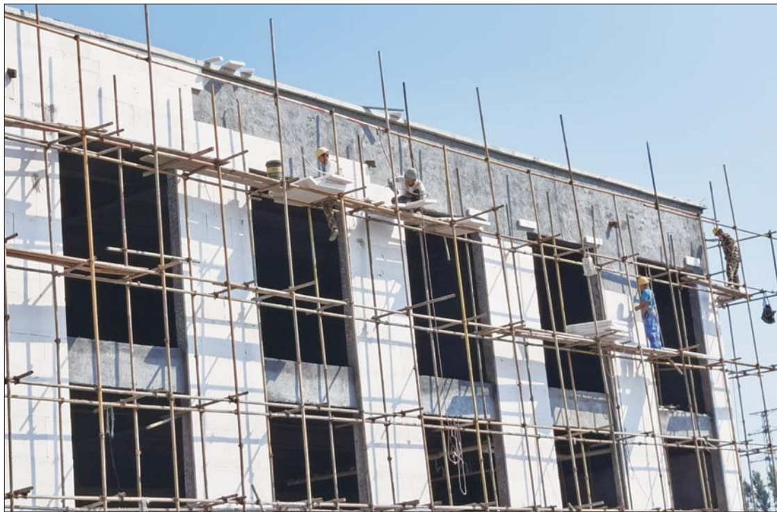
工人们正在激情高涨地忙碌。
