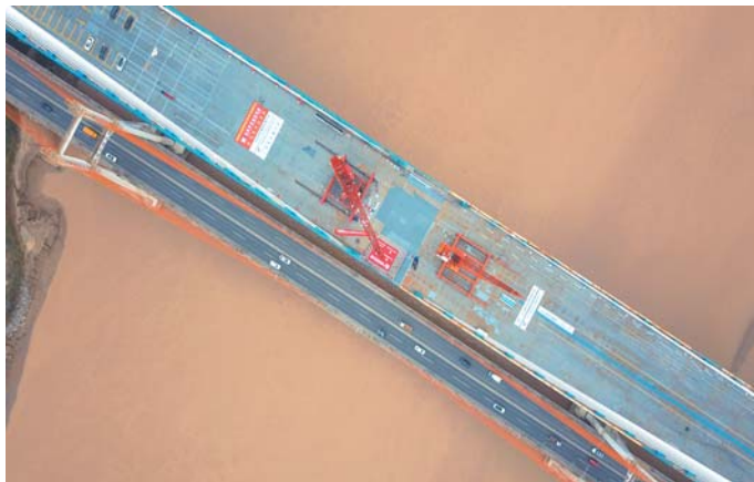
济南黄河大桥新桥与老桥并行,主跨跨径与老桥主桥等长。
