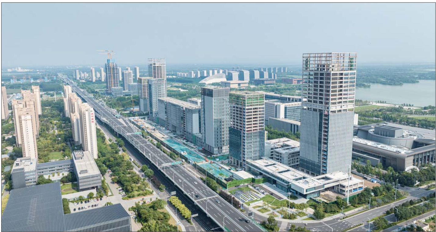
建设中的新天地商务中心。
