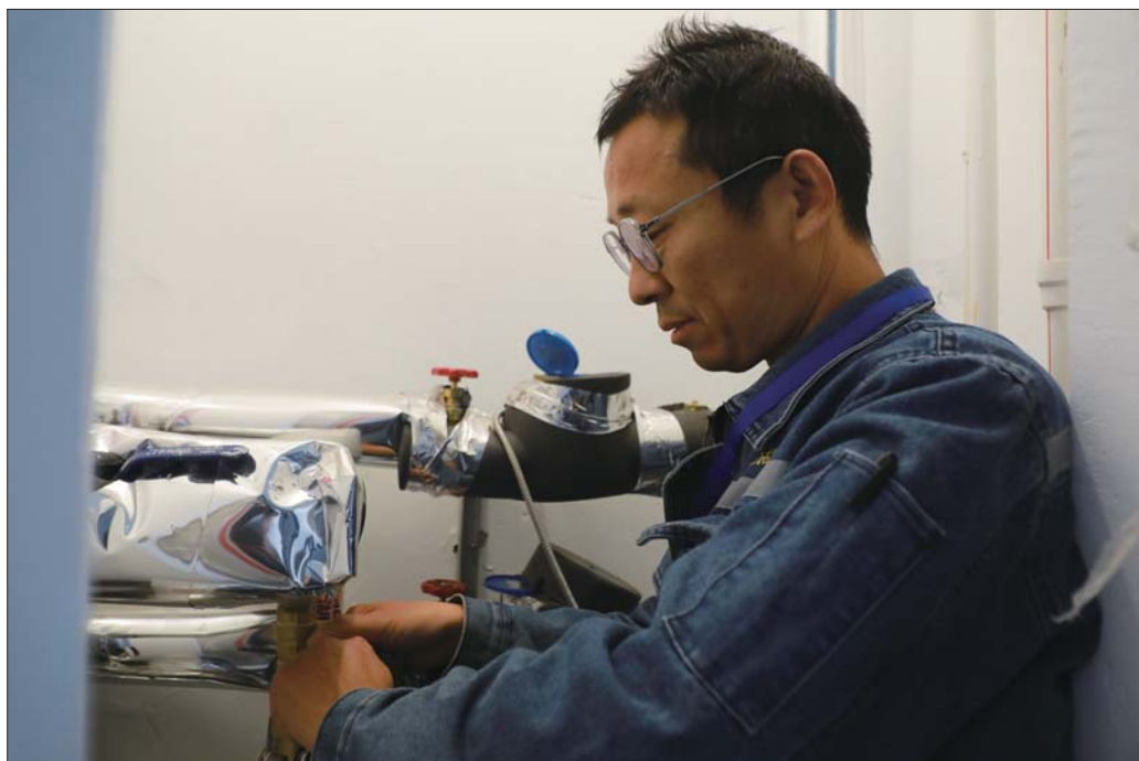
供热人员为用户上门试压。
