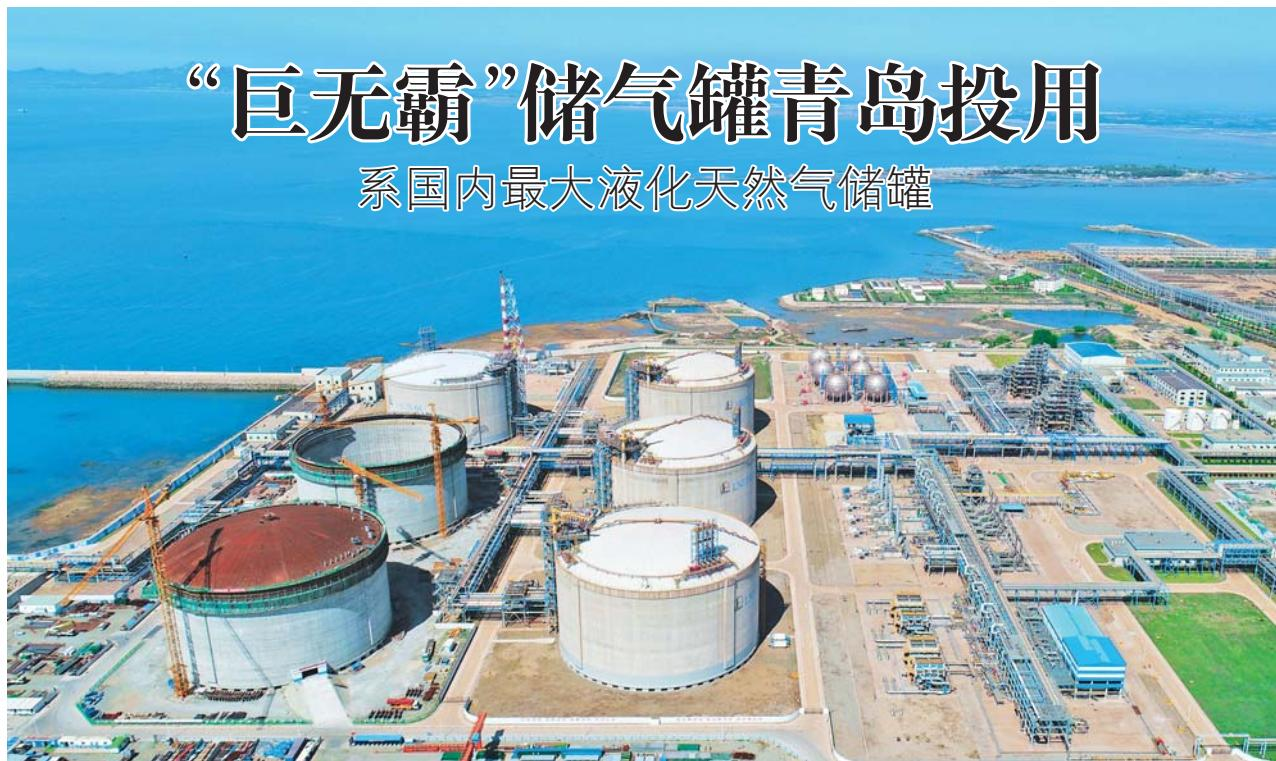
11月2日，我国自主研发的国内首座27万立方米液化天然气储罐在青岛投产，这也是目前国内容积最大、建设速度最快、首座完工的超大型液化天然气储罐，其直径达100.6米、高55米，罐内空间可停放一架国产C919大型客机。青岛液化天然气接收站是山东省目前唯一在用的液化天然气接收终端，供气范围覆盖鲁、苏、皖、冀、豫等省市，是我国华北地区的主要气源之一。该储罐的投产大幅提升了华北地区天然气供应保障能力。
