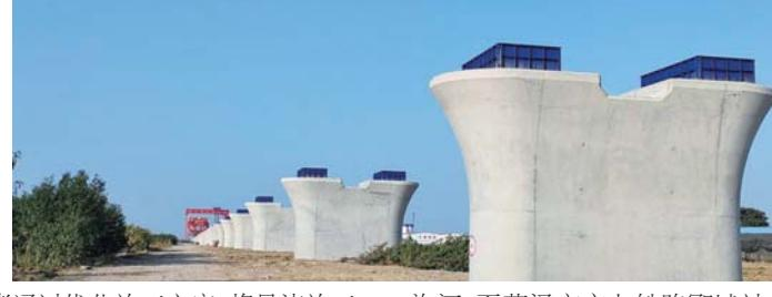
者通过优化施工方案,将悬浇施工调整为支架现浇施工,缩短工期5个月,也避免了梁体圬工进入冬期施工,并在支架结构设计上采用带防护棚与防抛网的钢管立柱与贝雷组合模式的支架体系,既降低对地方交通的影响,又保障梁下道路通行安全。
