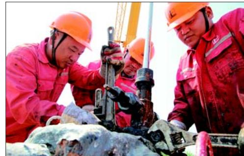
近日,在胜利油田鲁明公司济北采油管理区措施井曲9-平22生油现场,工作人员正在更换光杆,为该井开井做好准备。三季度以来,济北采油管理区抓住上产的黄金季节,加快施工运行节奏,由安全生产指挥中心统筹协调,组织各班站、工程公司、建设公司、信息公司、设备及电力维修厂家等单位有机调动,打好时间差,让每一道工序都无缝衔接。
