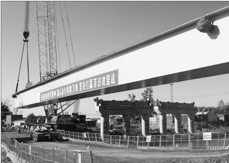
羊山运河大桥首跨钢结构箱梁架设成功。
