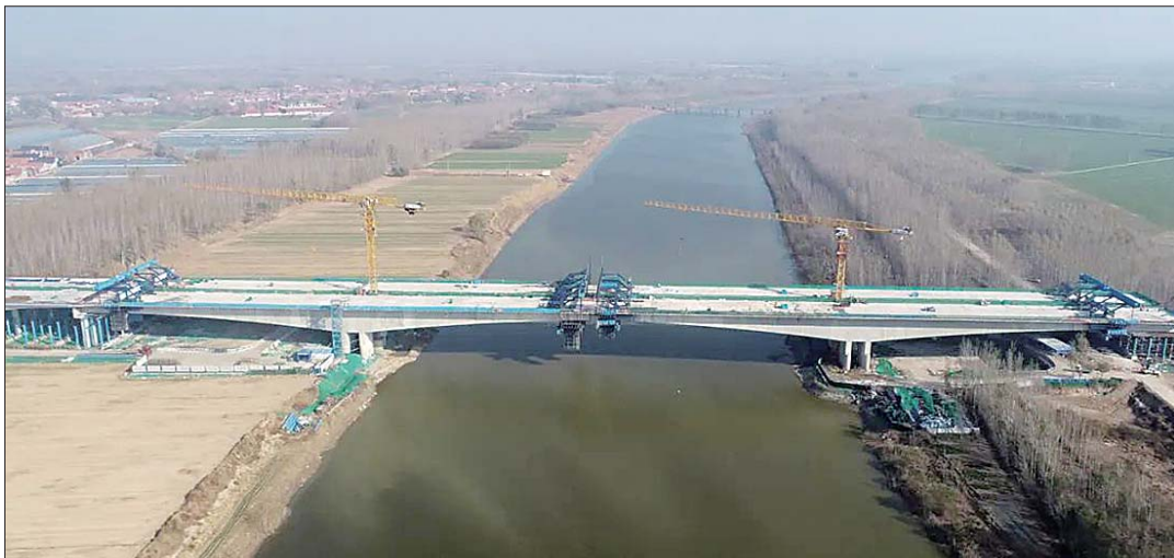
全长1248.5米,高商高速徒骇河特大桥顺利合龙。
