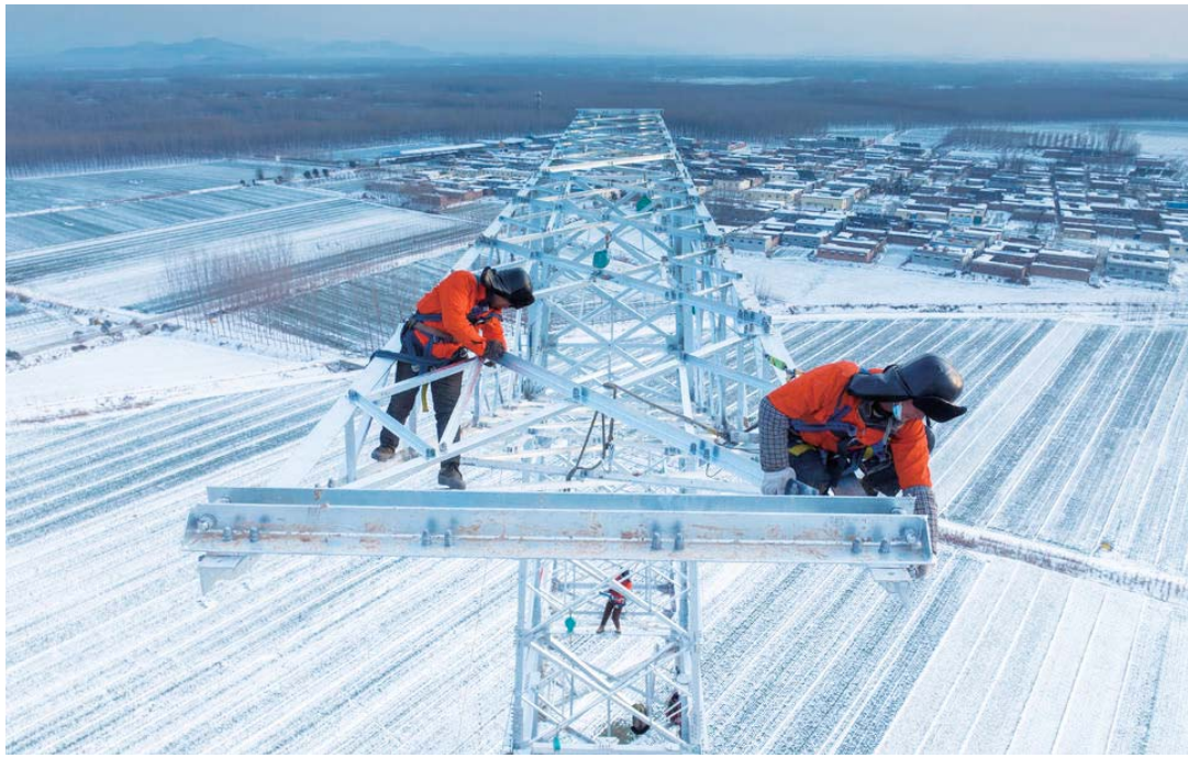
施工人员在冰天雪地里开展铁塔组立工作。
