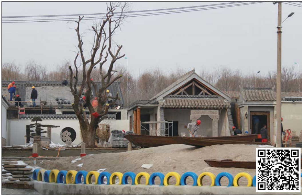
智运村项目施工现场。
