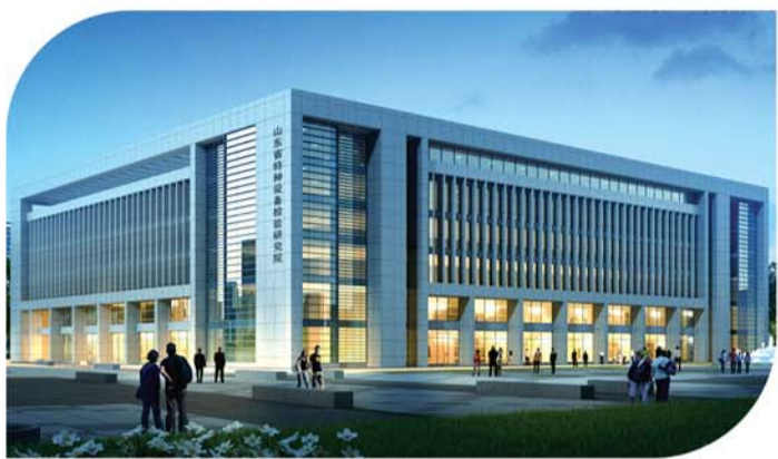
山东鲁南煤化工装备检验研究中心试验楼及研发楼。
