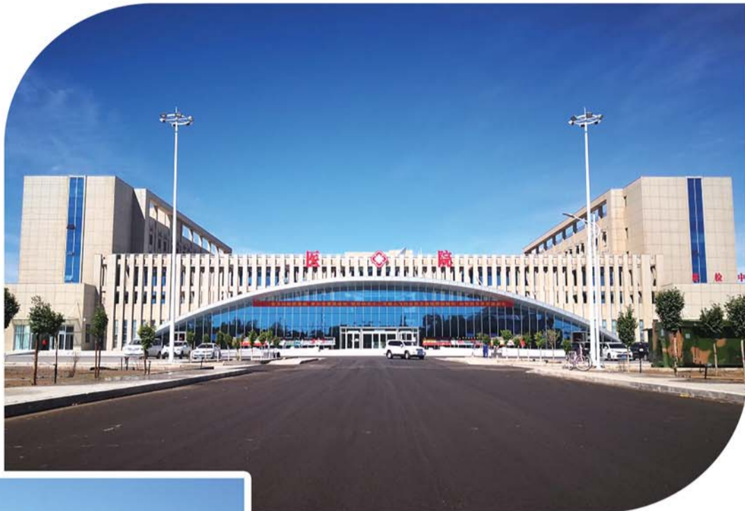
酒泉解放军513医院医疗综合楼。
