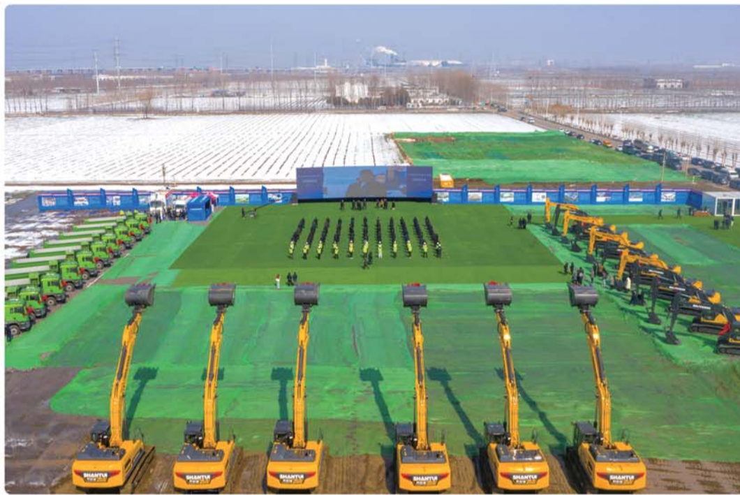
重大项目集中开工。
