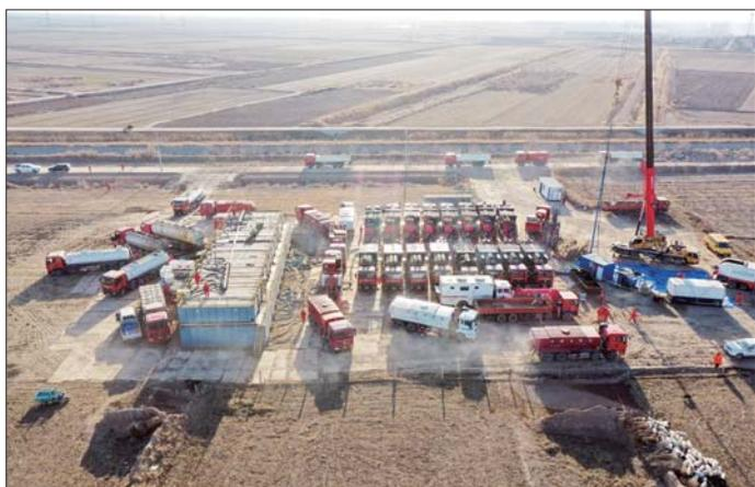
近日,胜利油田鲁明公司青南采油管理区滚评井通31—斜31井压裂施工现场,16台压裂车组采取缝网压裂工艺,顺利完成205立方米加砂,为科学评价东营凹陷中深层“夹层型”页岩油商业开发潜力奠定坚实基础。
