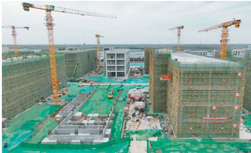
在经济开发区宏堂制药(商河)有限公司产业基地施工现场,工人们正忙着加工铺设厂房地面钢筋。
