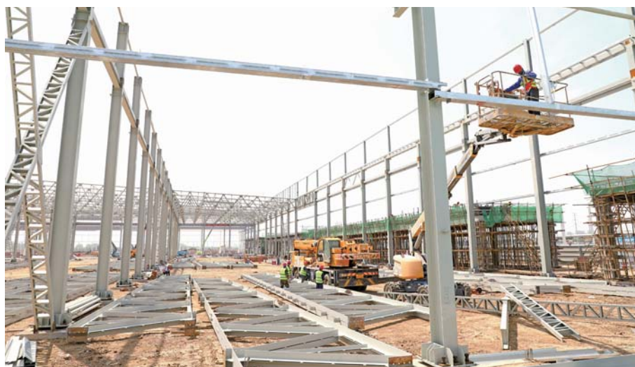
正在建设中的小松全球智能制造产业基地项目
