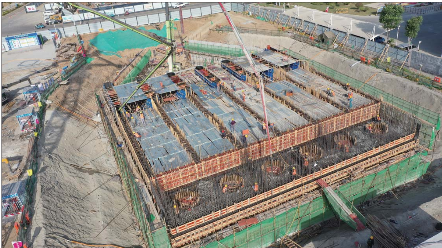
石佛泵站工程建设现场。
