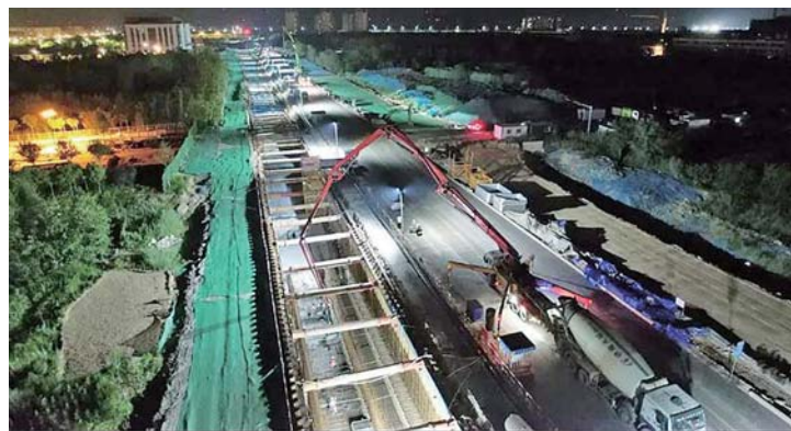
商河县各处交通项目工地上热火朝天。
