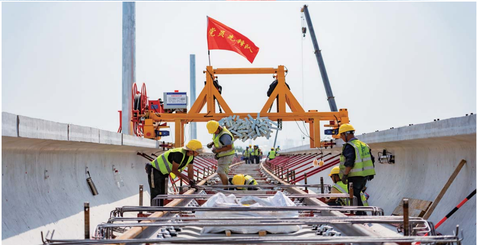
在济南轨道交通8号线，党员先锋队正大干快上忙建设。
