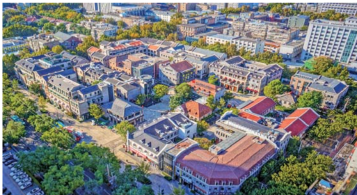
有机更新助推泉城旧貌换新颜。
