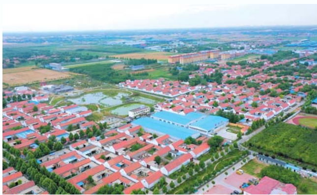
孟庄铺村以“书香儒韵”为定位，实施乡村振兴铸魂工程。
