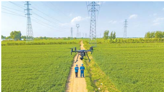
供电员工正在利用无人机巡检沿黄输电线路。
