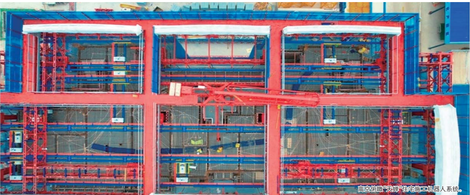
高空俯瞰“天蝉”住宅施工机器人系统。
