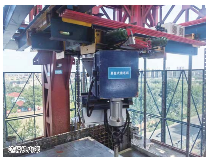
青岛黄埠岭片区棚户区改造项目，3号楼正在使用造楼机进行建造，从外观看，就是一个蓝色大箱子包裹在楼顶。
