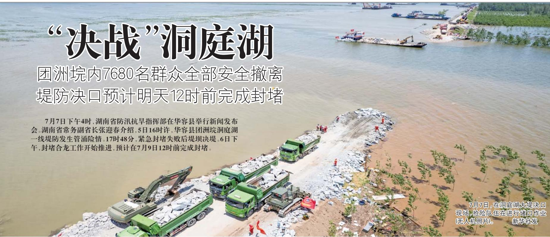
7月7日,在洞庭湖大堤决口现场,抢险队伍正在进行堵口作业(无人机照片)。新华社发
