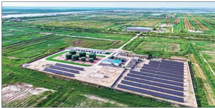
胜利油田河口采油厂在渤南注水站,利用闲置土地建成的光伏电站,每天源源不断向油区提供“绿”电,形成一幅光伏、油井与生态环境相和谐的壮美画卷。今年上半年,已建成的13兆瓦发电装置,累计发电1041.58万千瓦时,减少碳排放8947吨。
