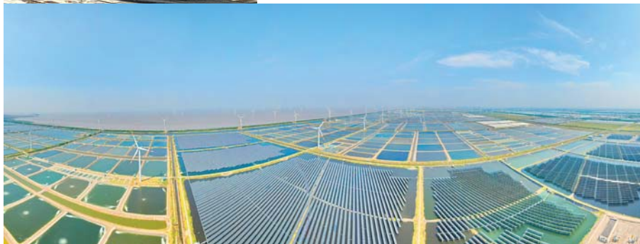
光伏产业—渔光一体项目。
