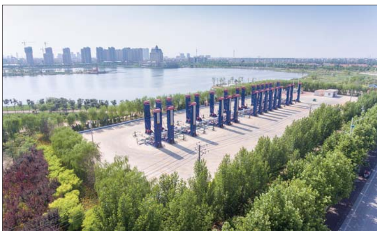
胜利油田滨南采油厂白鹭湖“井工厂”的油水井。 通讯员 于茂华 摄
