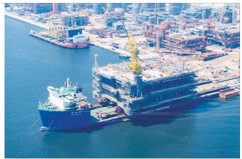
8月12日,由海洋石油工程(青岛)有限公司承建的马赞油气集输平台在青岛完工交付,将于近期搭乘运输船,前往6400海里以外的沙特阿拉伯海域进行安装。这是世界上原油集输能力最强的海洋平台之一,也是中国建造的最大国际海洋油气平台,标志着我国大型海洋油气装备建造技术取得新突破。马赞油气集输平台甲板面积相当于15个篮球场,高度超过24层楼,每年能汇集输送原油2400万吨,可为近5亿辆小汽车加满油。 赵波 青岛报道
