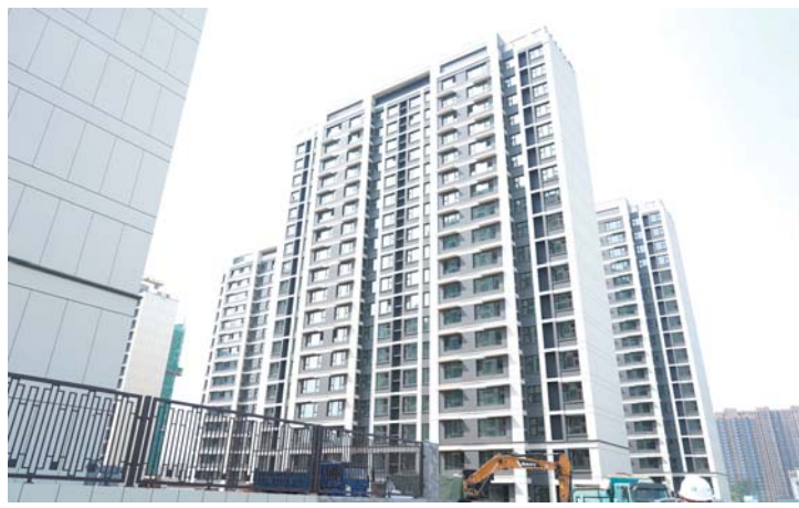
南城子坡城市更新项目安置房大部分基本建成。
