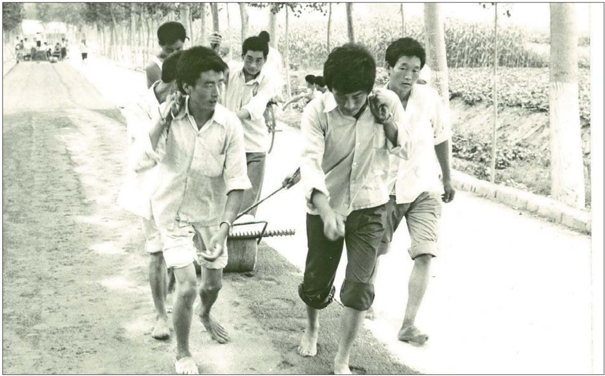
上世纪80年代公路养护人员用石碾子对路面进行碾压。
