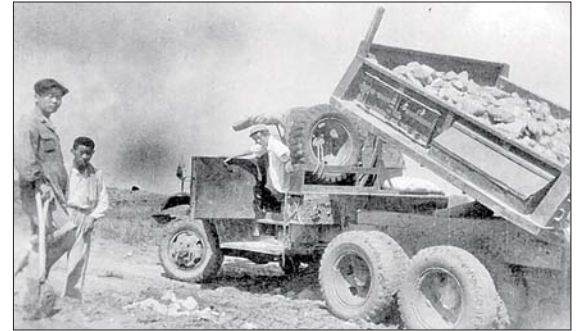
新中国成立初期,山东省公路运输局进行碎石路面施工。
