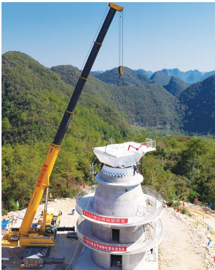
9月25日,首台核心阵试验样机在吊装中。 新华社发
