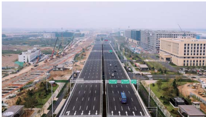
济南机场主进场路9月29日顺利通车。
