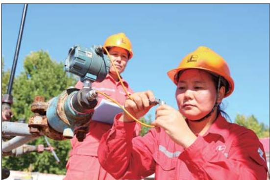
员工连接温压一体变送器航空插头。
