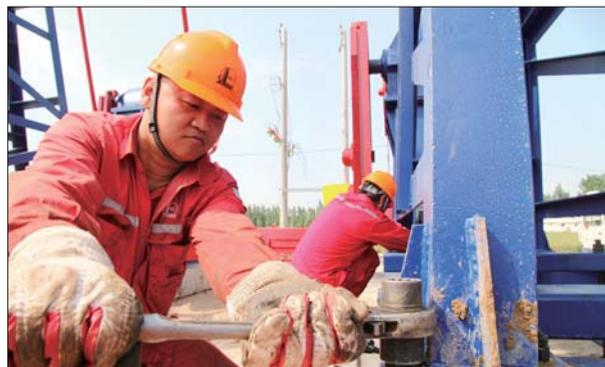
员工紧固抽油机压杠螺丝。
